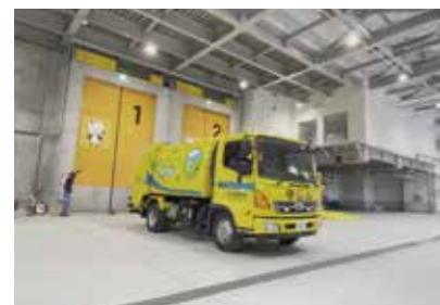
プラットフォーム 収集車はごみ投入扉からごみピットへごみを投入します。出入口には高速シャッターとエアカーテンを設け、臭気の外部漏洩を防いでいます。
